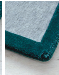
Doblado interior moqueta con backing de fieltro
