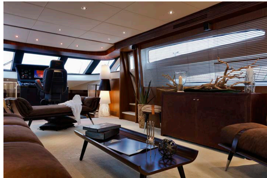
Colocación de moqueta en yate privado.
